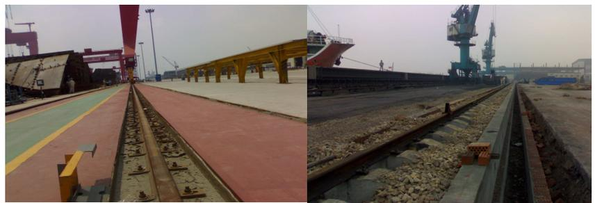
离偏差 ≤±5mm；厂房横向同一位置上两条轨道顶面的相对标高差：柱子 ≤10mm 其它处 ≤15mm
