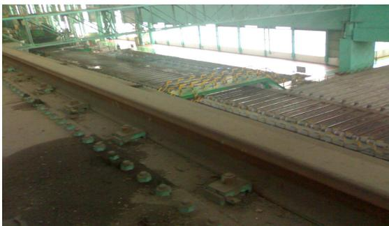
S-WJK 型（缩小型焊接型压轨器）轨道连接件
