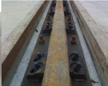
可调式柔性压轨器是我公司设计的主要应用于港口起重机轨道的紧固件产品，主要用于起重量在 275t 以下的，环境温度小于 70℃ 的，且吊车轨道固定槽口较窄的轨道的固定。
