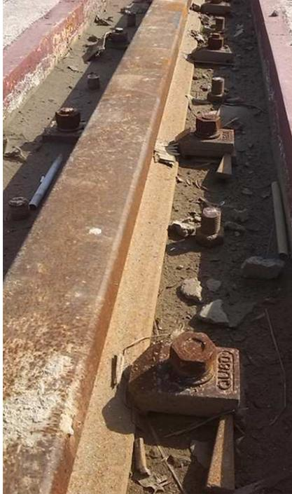
固定件底座与吊车梁焊接，
