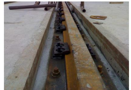
☆底座板与钢吊车梁上翼缘焊接，可将吊车横向力平稳均匀地传递给吊车梁。避免了在吊车梁上翼缘大量开孔引起的削弱翼缘截面的缺陷。有效地提高了吊车梁截面强度和承载力。由于橡胶压舌和橡胶垫板的作用，具有缓冲和减震，及降低噪音之功能。
